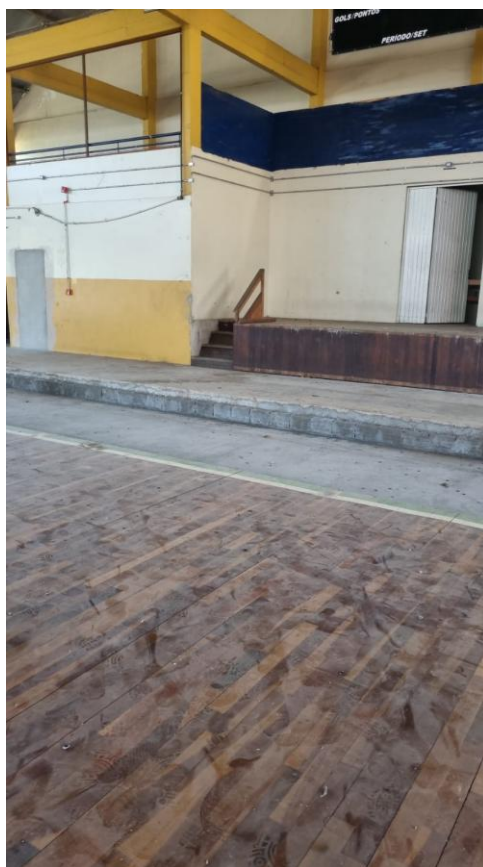
03/02/2026 — Detalhe do piso de madeira (taco) recém-instalado, ainda sem o acabamento final.
