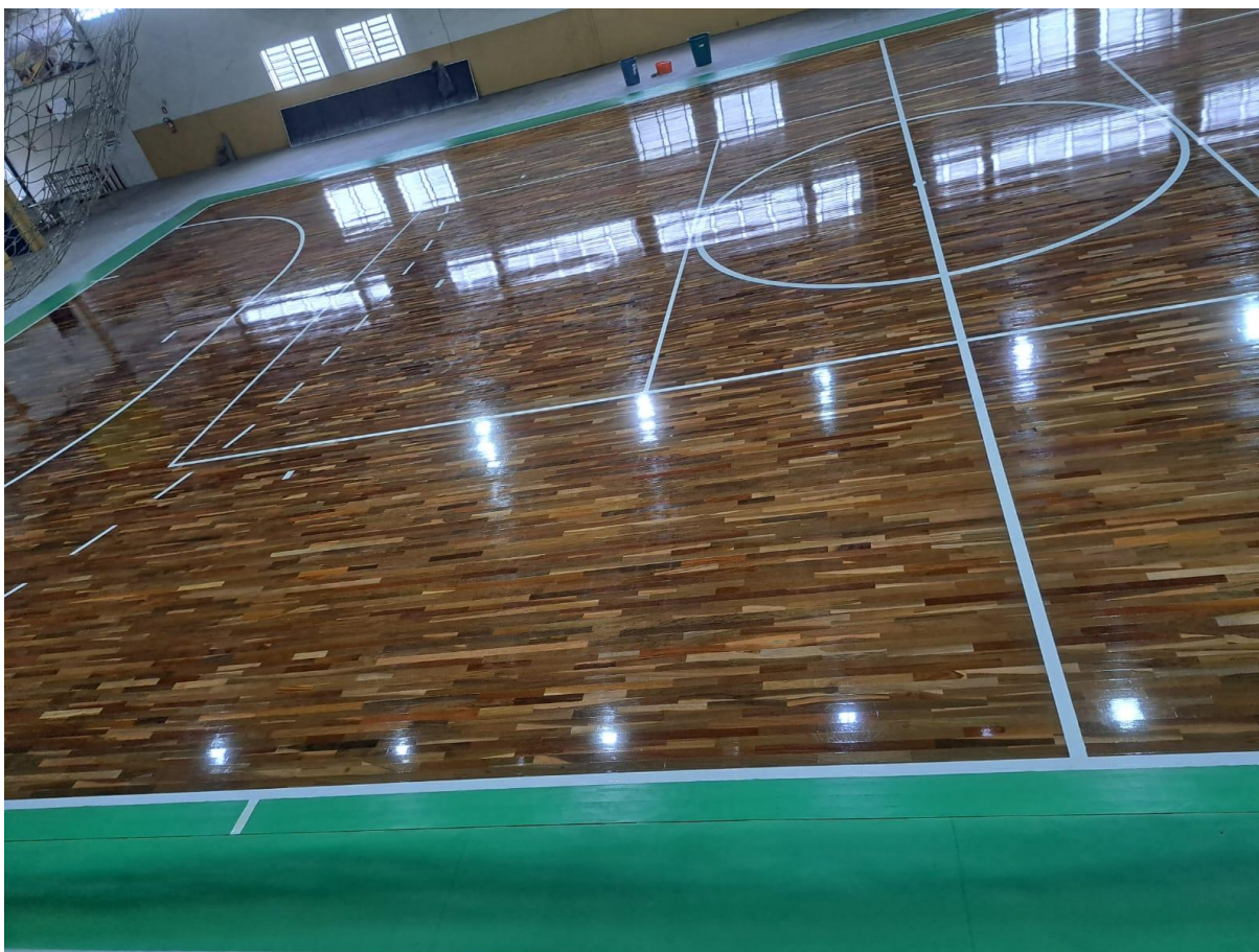
14/04/2026 — Piso da quadra finalizado, com marcações esportivas já pintadas em branco.
