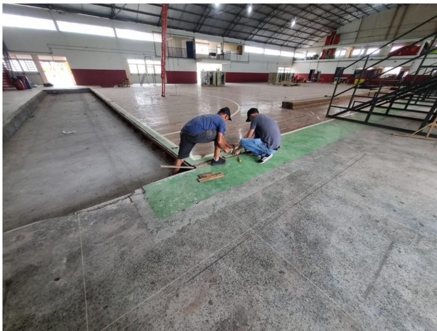
24/02/2026 — Operários iniciando a remoção das madeiras.
