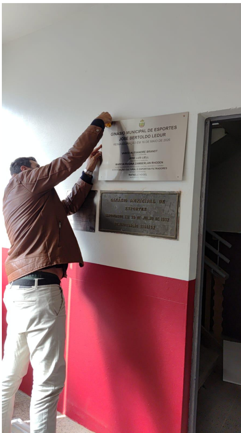
12/05/2026 — Instalação da placa de identificação do ginásio na parede interna.
