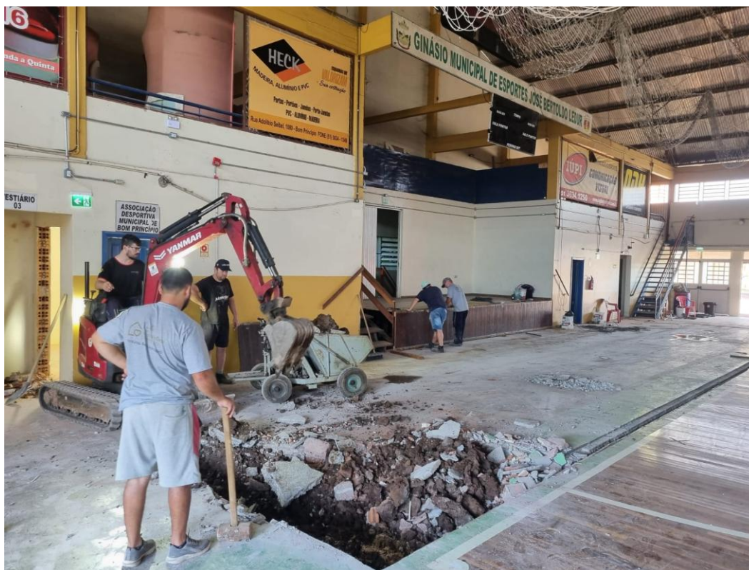
07/01/2026 — Equipe realizando a remoção de entulho da quadra, com pá e carrinho de mão, durante a etapa de demolição, para ampliação da quadra.
