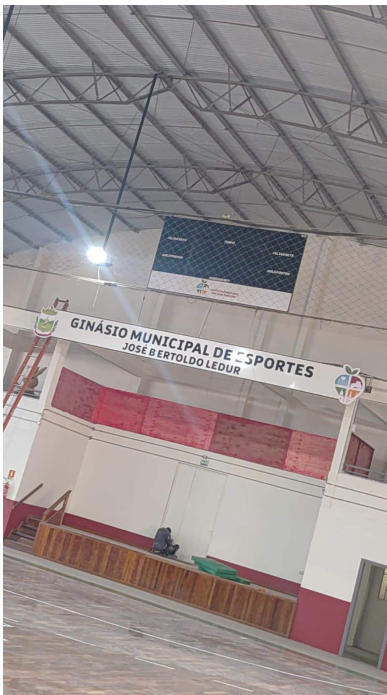
12/05/2026 — Vista interna do ginásio com o letreiro "Ginásio Municipal de Esportes" já instalado.
