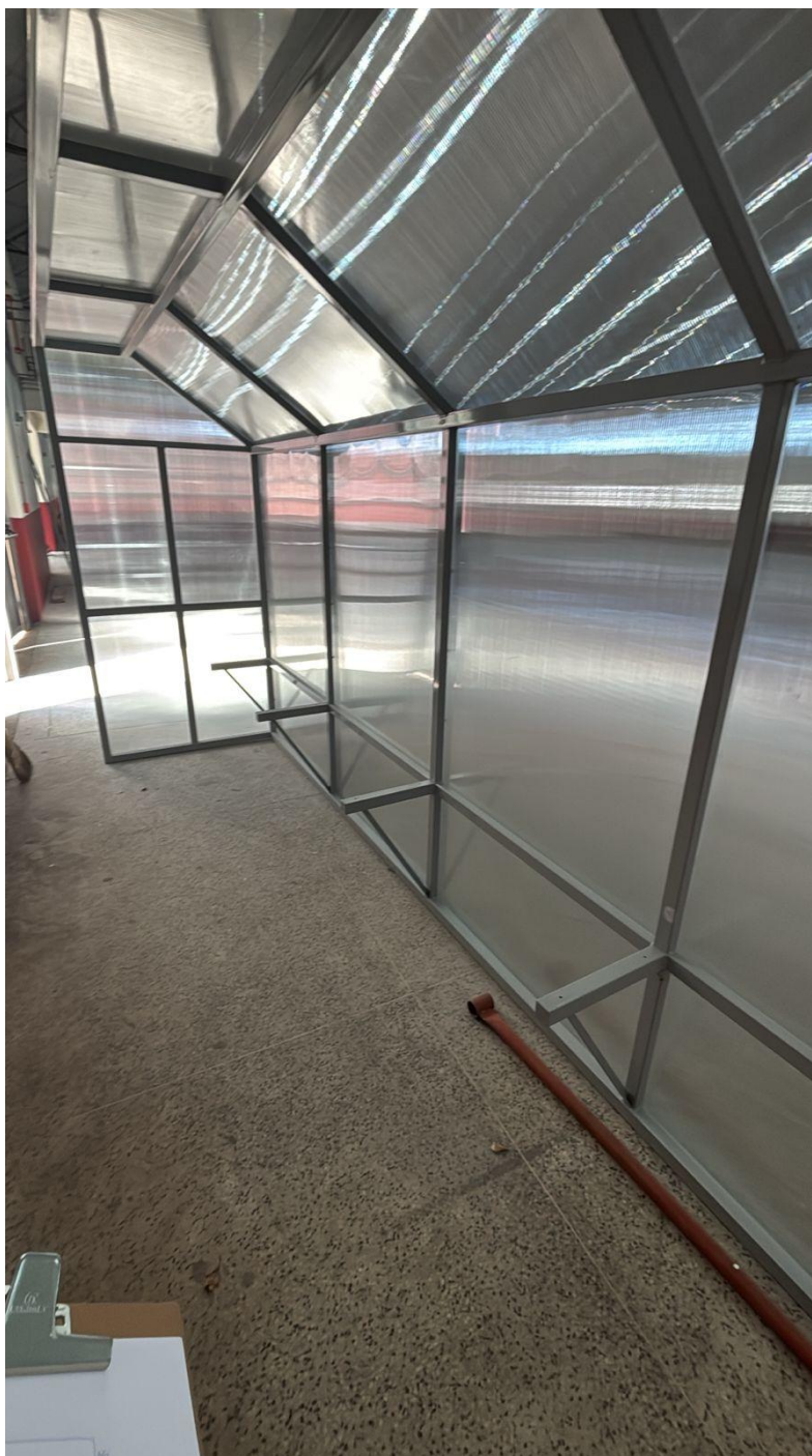
11/05/2026 — Estrutura de grades/corrimão metálico em fase de instalação.
