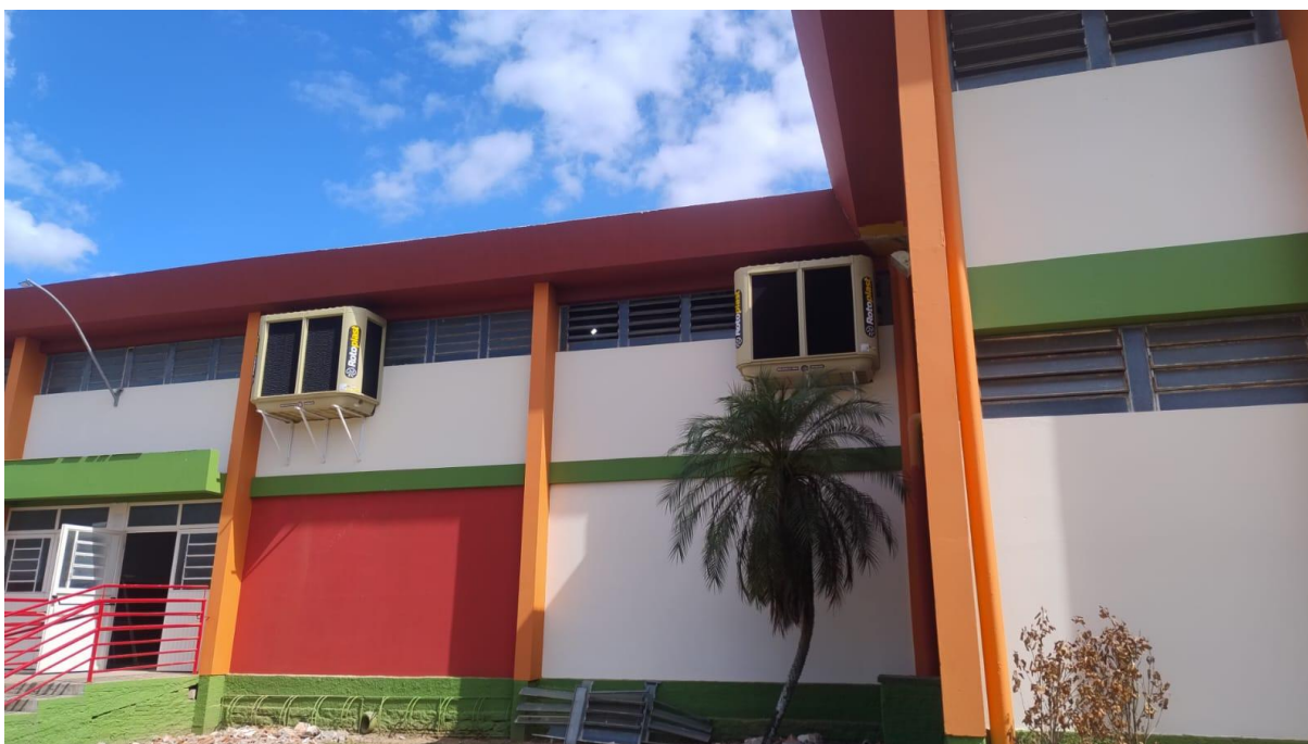
26/02/2026 — Fachada frontal do ginásio com aparelhos de ar-condicionado instalados.
