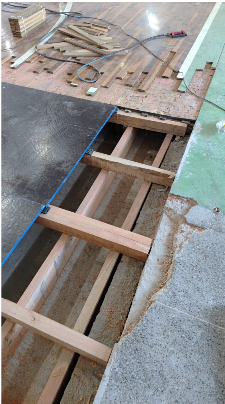
05/03/2026 — Detalhe da nova estrutura do piso elevado, com vigas de madeira expostas antes do fechamento do assoalho.
