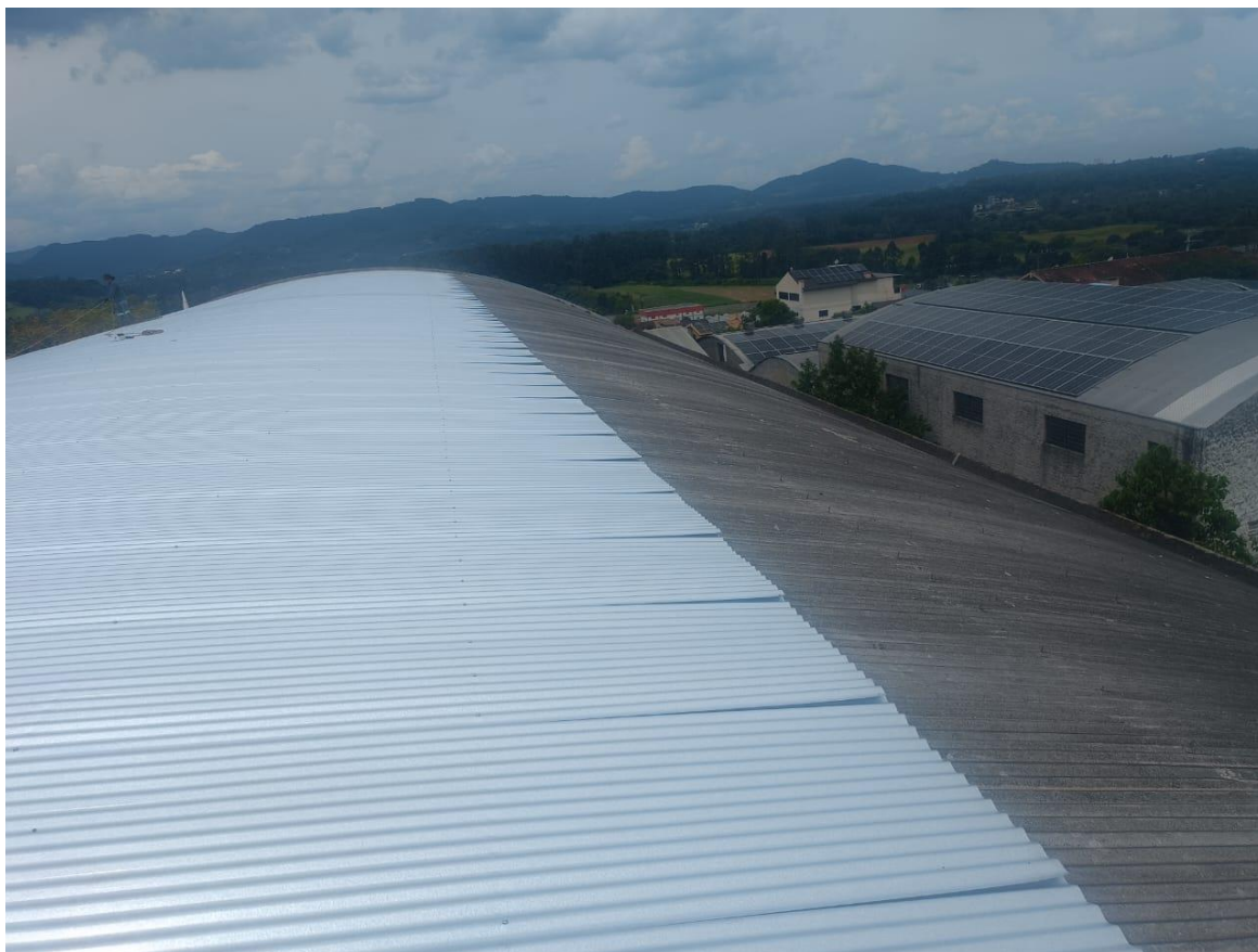
09/02/2026 — Detalhe da transição entre o telhado novo e a cobertura antiga, durante a obra.
