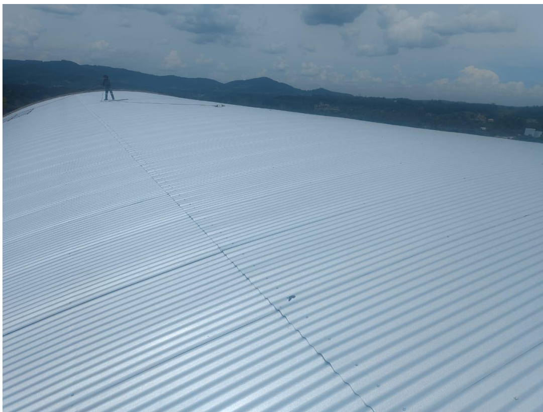
09/02/2026 — Operário realizando a instalação das telhas metálicas sobre a cobertura.
