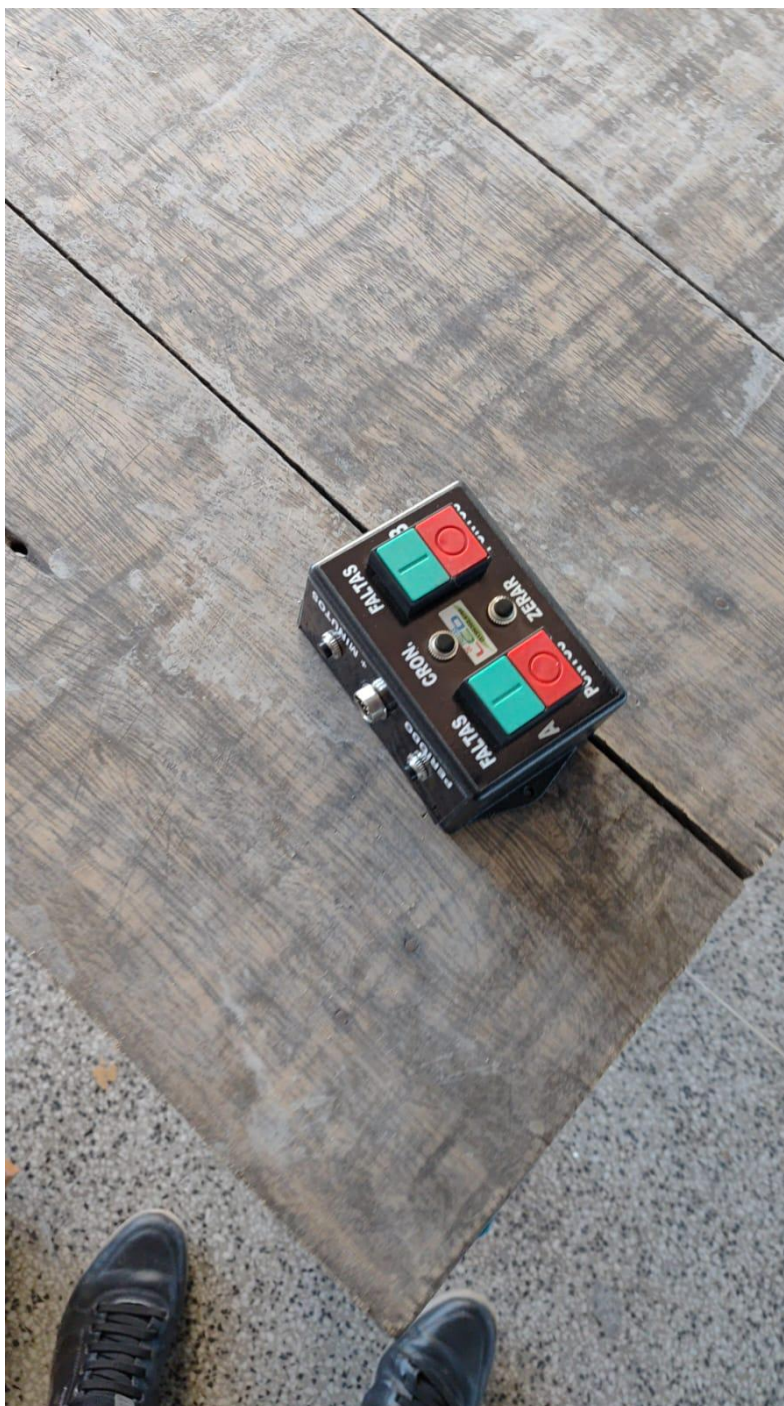
08/05/2026 — Detalhe de quadro/botoeira elétrica apoiada sobre o piso de madeira, durante instalação dos comandos elétricos.
