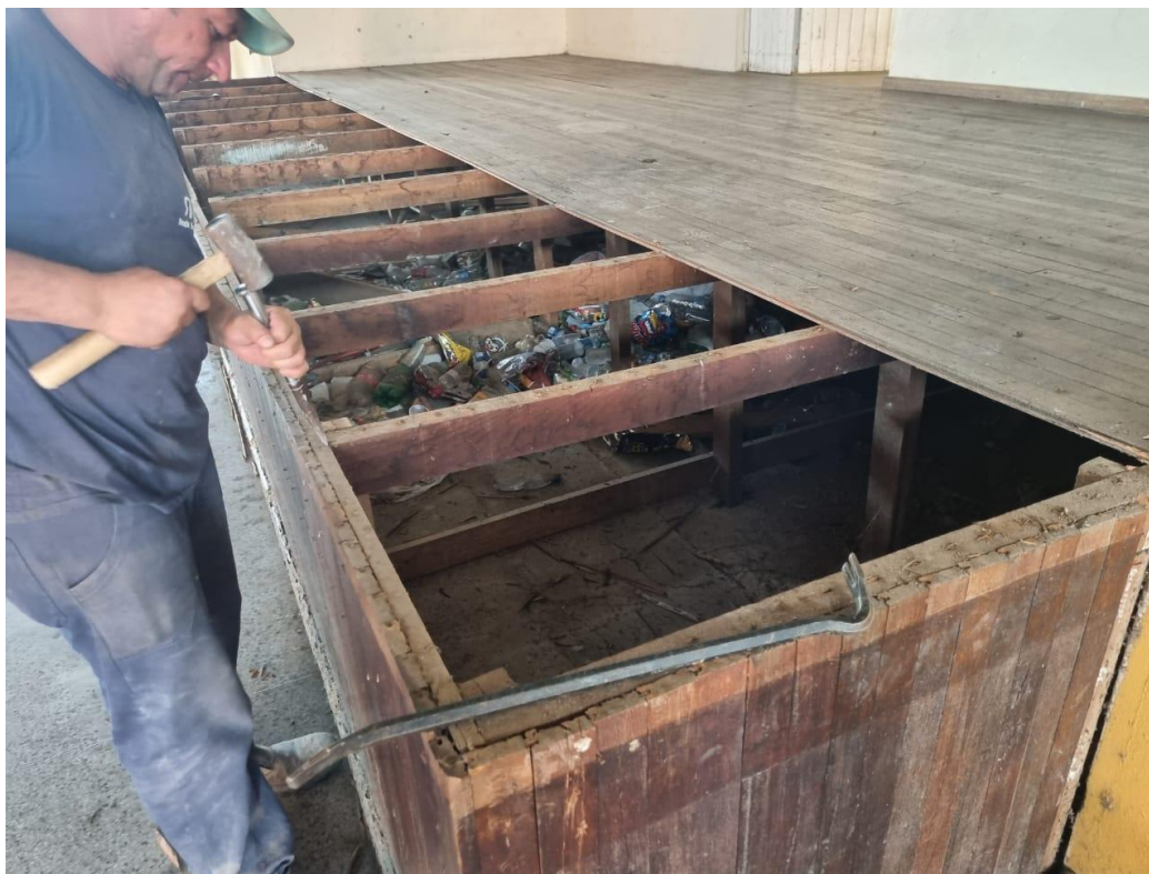
06/01/2026 — Remoção da estrutura de madeira do palco.
