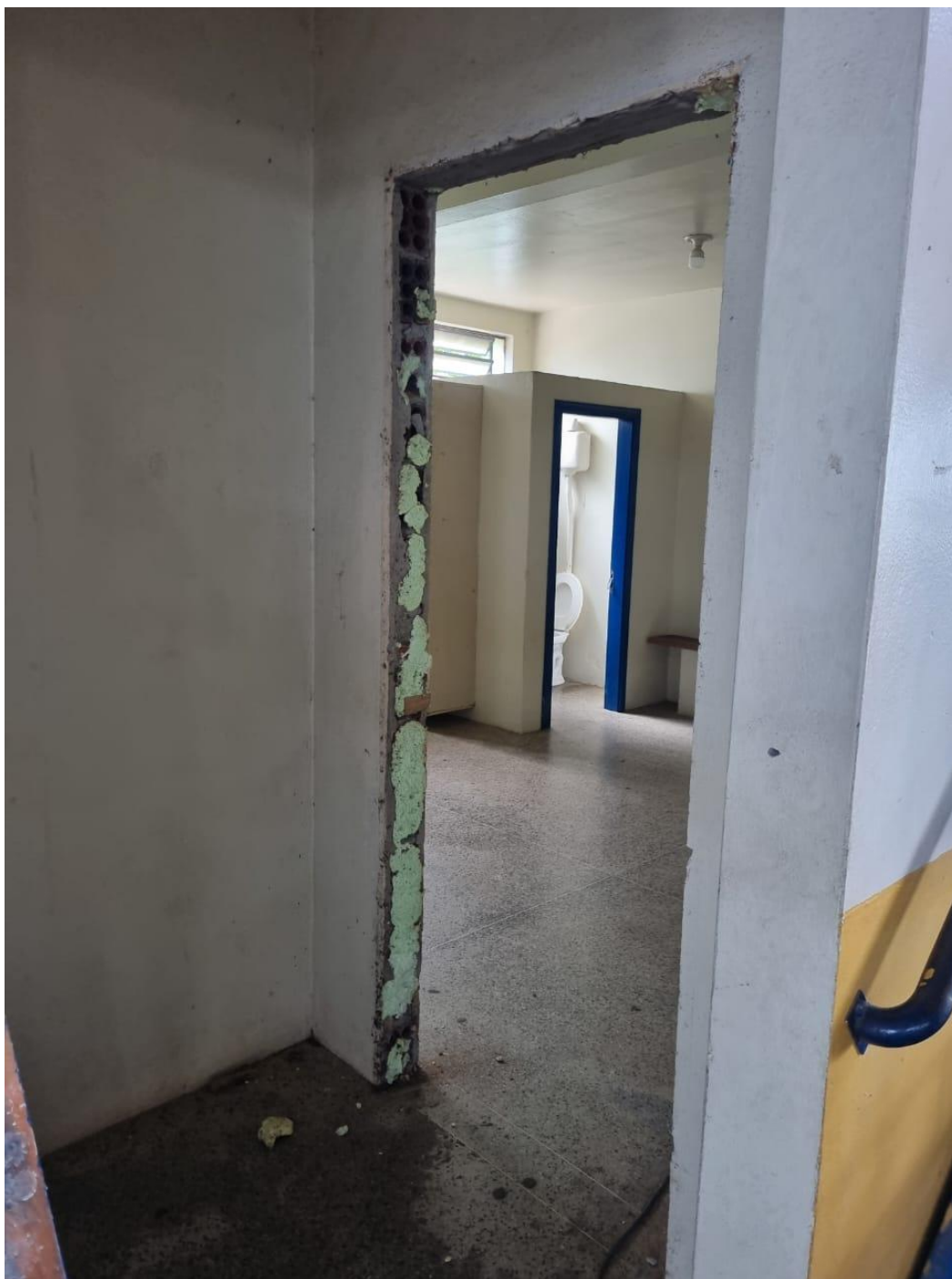
06/01/2026 — Vão de porta em reforma, com abertura de alvenaria para instalação de nova esquadria.
