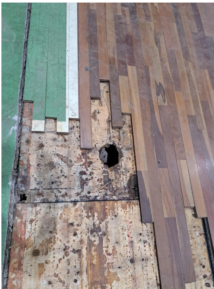
24/02/2026 — Trecho do piso de madeira antigo sendo removido, evidenciando a deterioração da base antiga.
