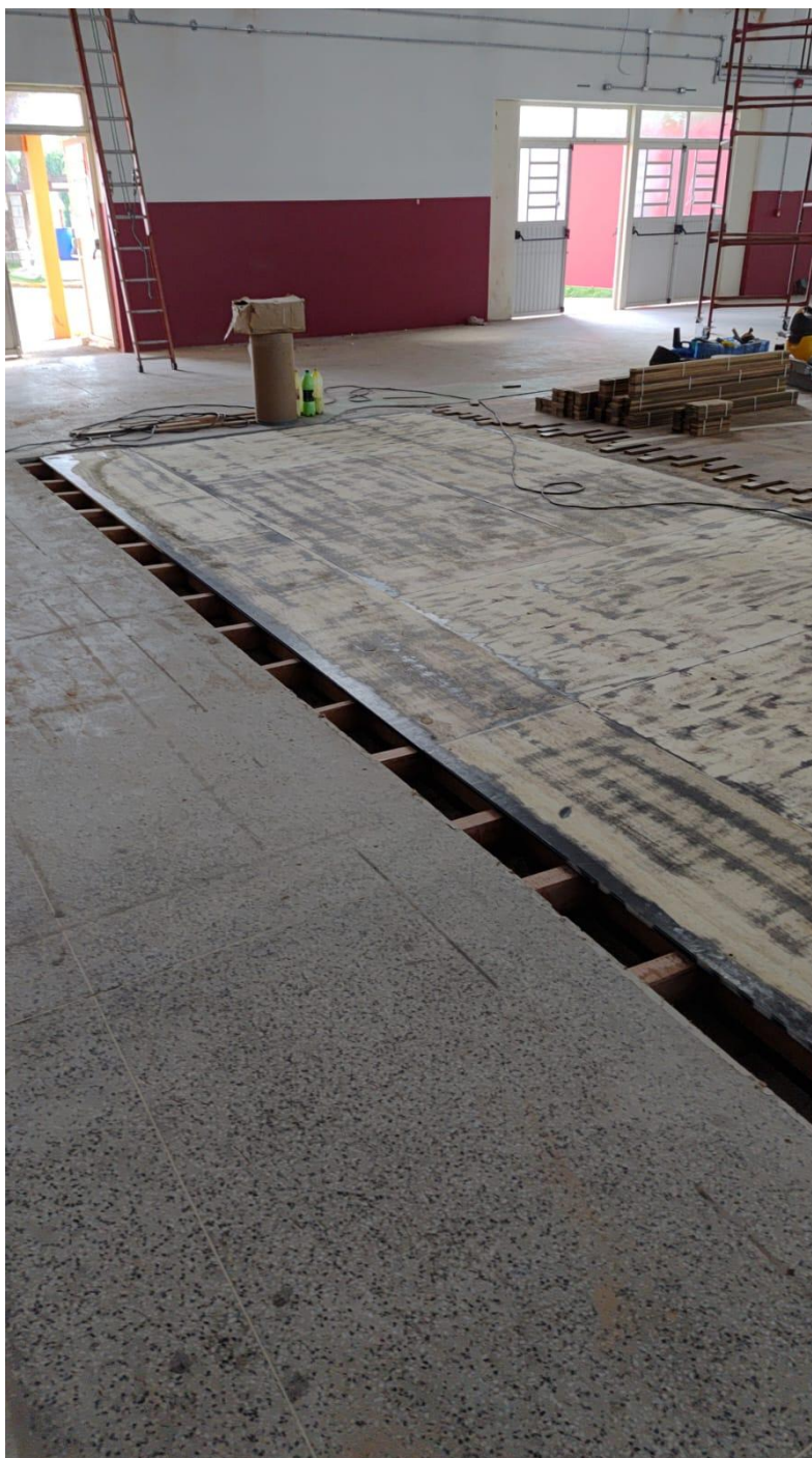
05/03/2026 — Vista geral do ginásio com o piso em fase de reconstrução, mostrando o avanço dos trabalhos.
