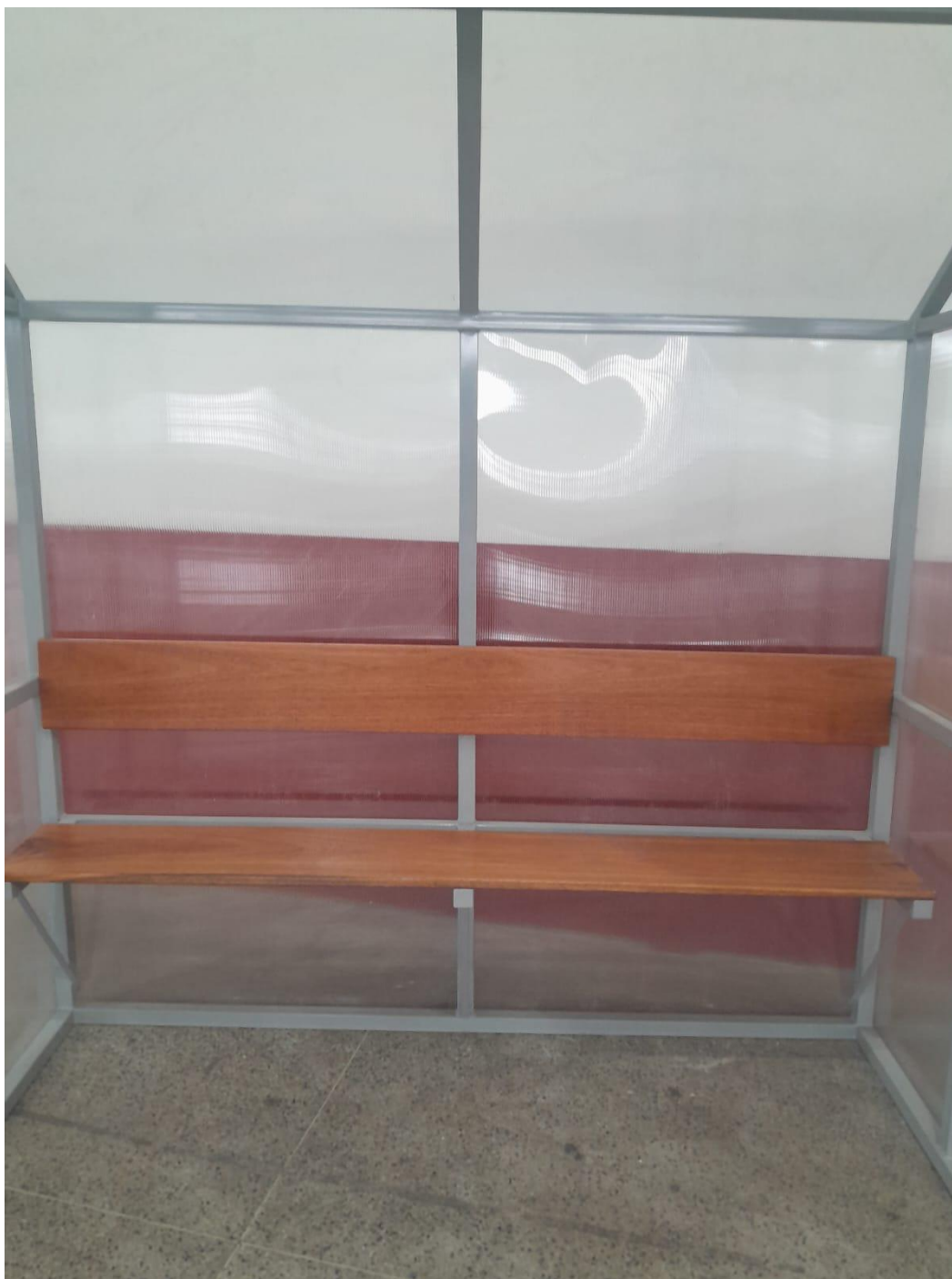
15/05/2026 — Estrutura metálica da arquibancada com os primeiros assentos de madeira já instalados.
