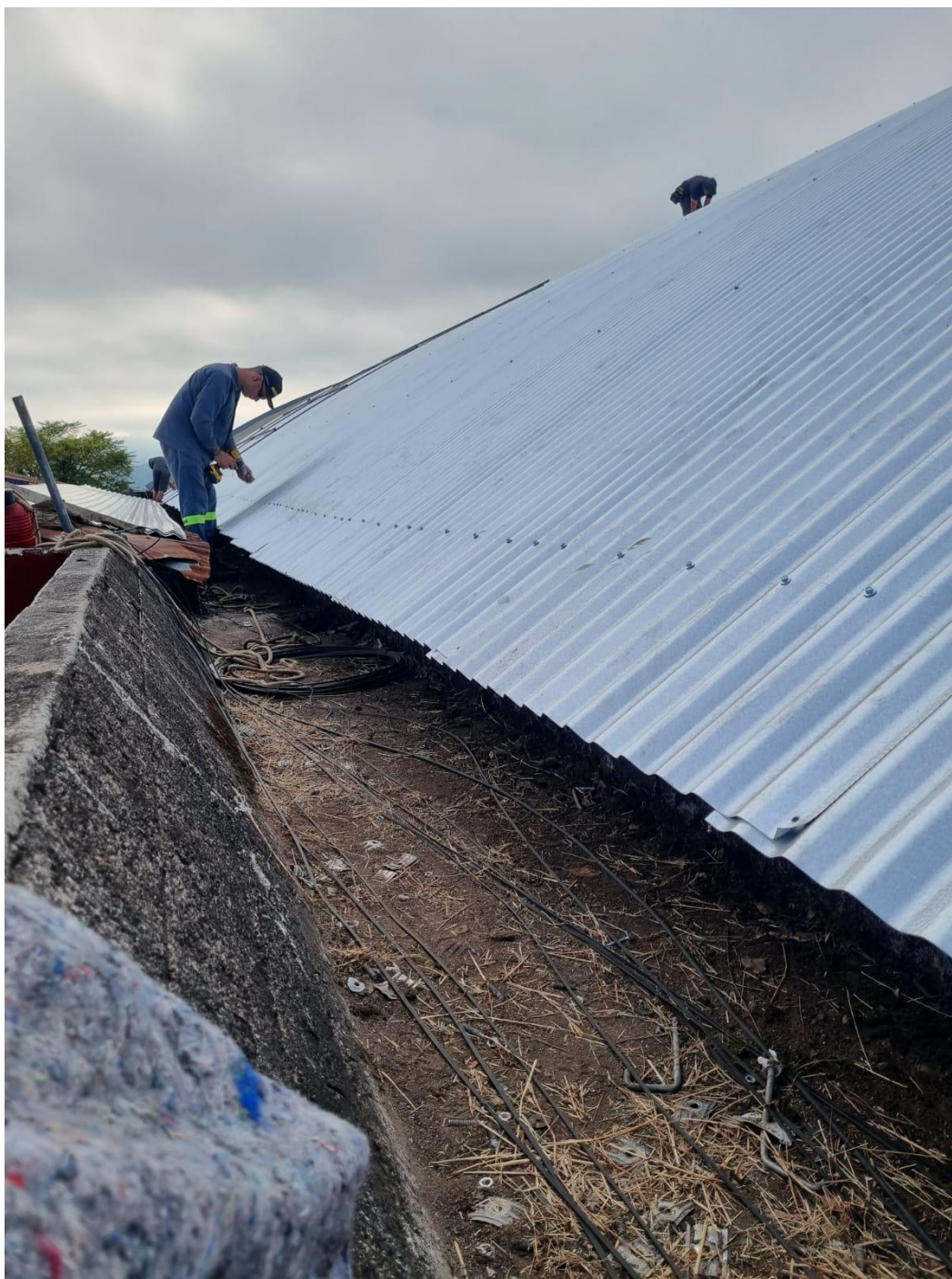
29/01/2026 — Instalação das telhas metálicas de cobertura.
