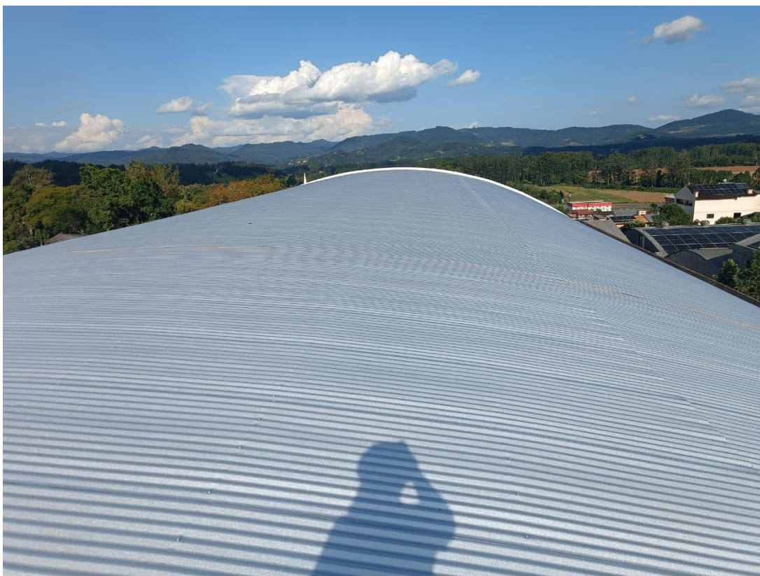
09/02/2026 — Vista do telhado com as novas telhas metálicas instaladas em toda a extensão da cobertura.
