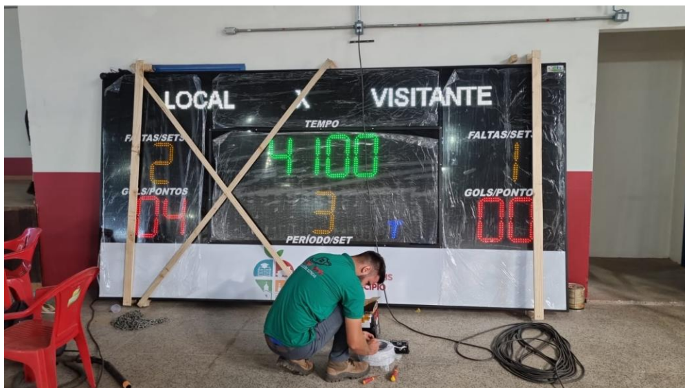
01/04/2026 — Operário montando o placar eletrônico definitivo, suspenso na estrutura do ginásio.
