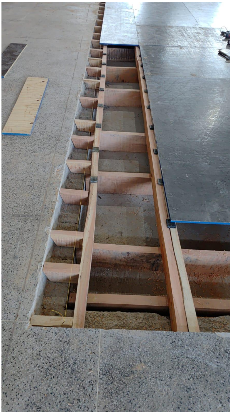
05/03/2026 — Vista da estrutura de sustentação do piso (barroteamento) sendo reconstruída.
