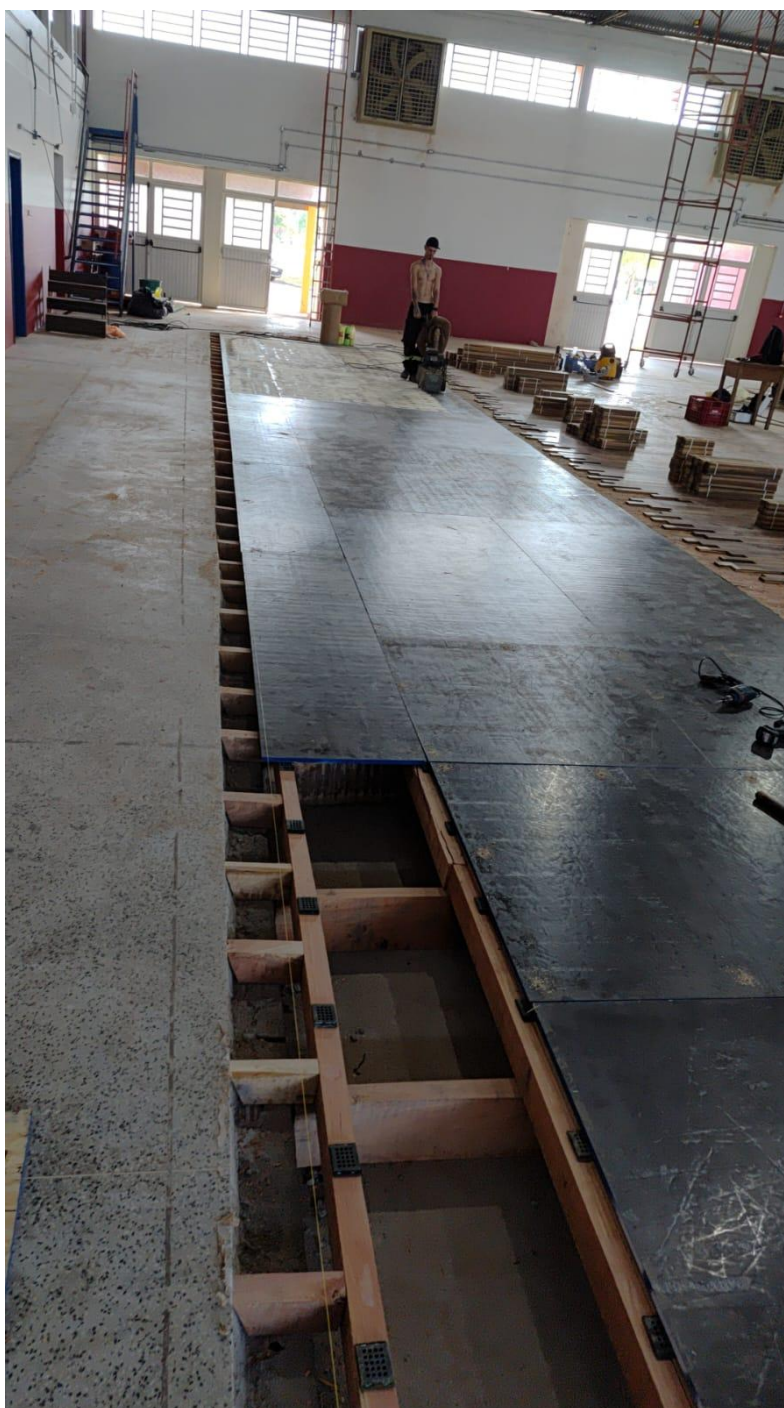
05/03/2026 — Trecho do piso já fechado com placas de madeira de base, preparado para receber o revestimento final.
