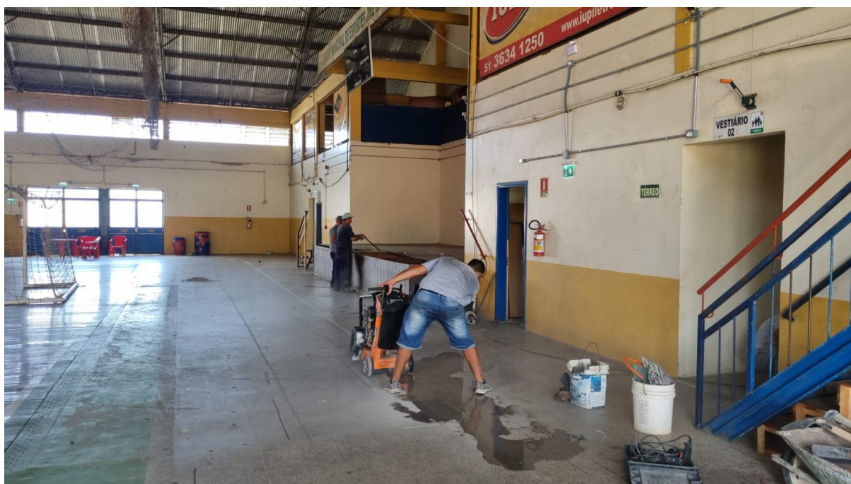
06/01/2026 — Início dos trabalhos de reforma, com remoção de revestimentos para ampliação da quadra.
