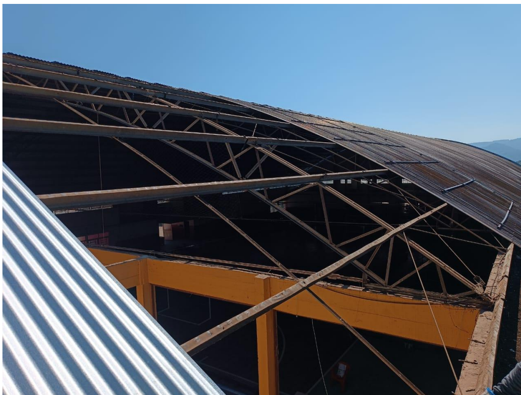
09/02/2026 — Vista interna da estrutura metálica da cobertura durante a instalação das telhas, com parte do telhado ainda aberta.
