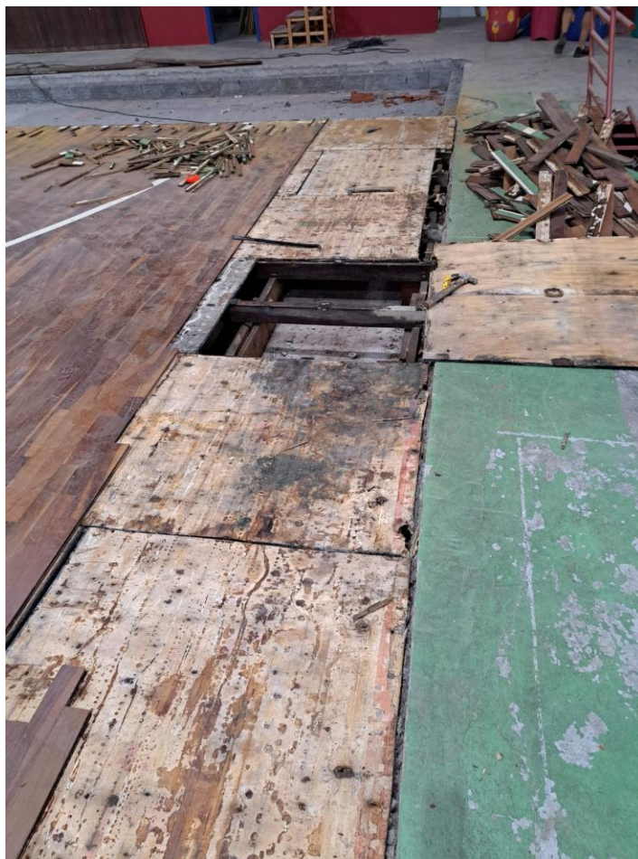
24/02/2026 — Continuação da retirada do piso antigo.
