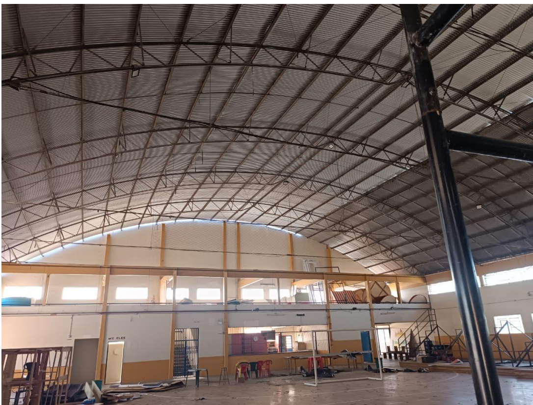
09/02/2026 — Vista interna do ginásio com as 70% das telhas novas instaladas.
