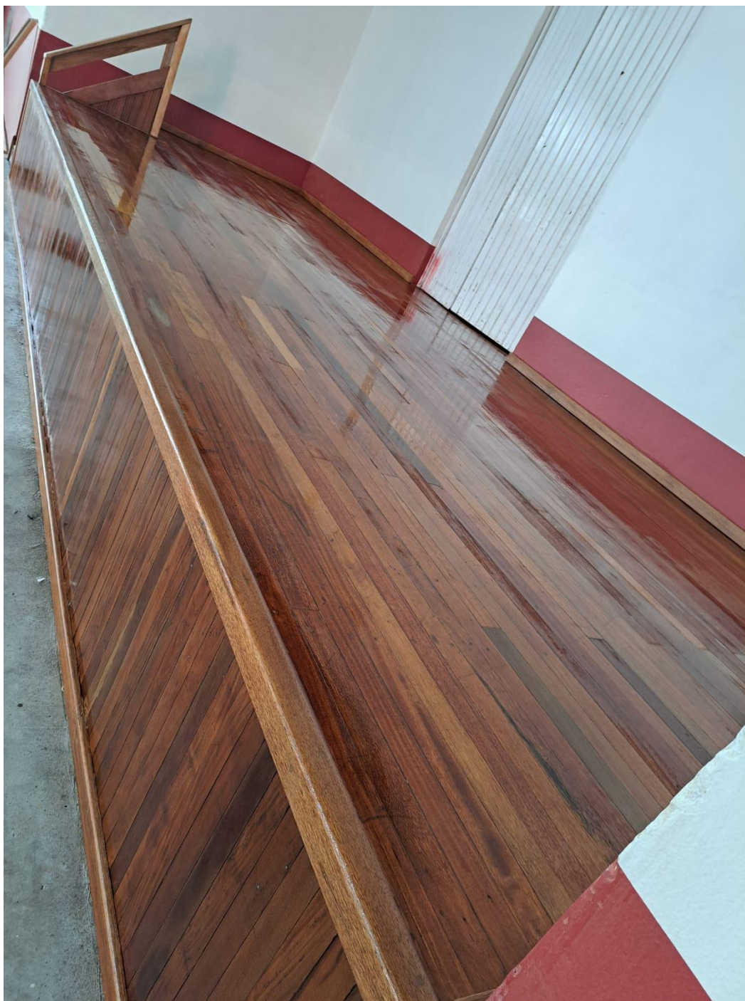
14/04/2026 — Detalhe do acabamento do piso de madeira junto ao rodapé, no palco.
