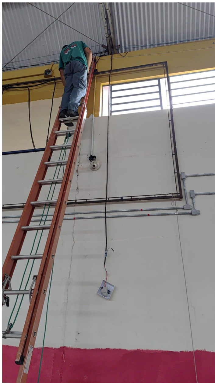
03/02/2026 — Manutenção elétrica na parte alta do ginásio.
