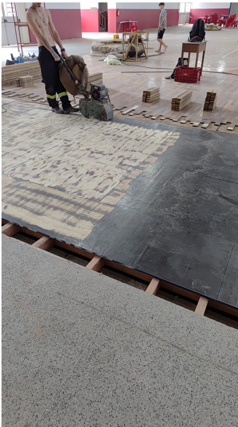
05/03/2026 — Operário trabalhando na finalização da base do piso elevado da quadra.
