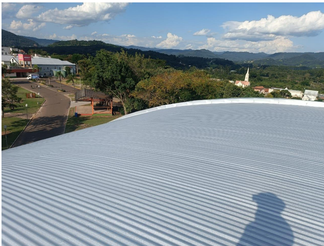
09/02/2026 — Vista panorâmica da cobertura metálica já instalada.
