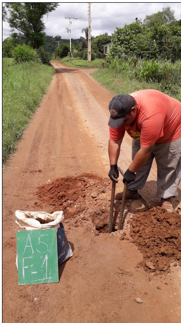
FURO DE SONDAGEM - AS - F1
