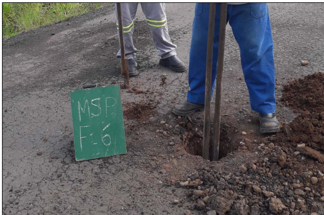
FURO DE SONDAGEM - MSP F-6
