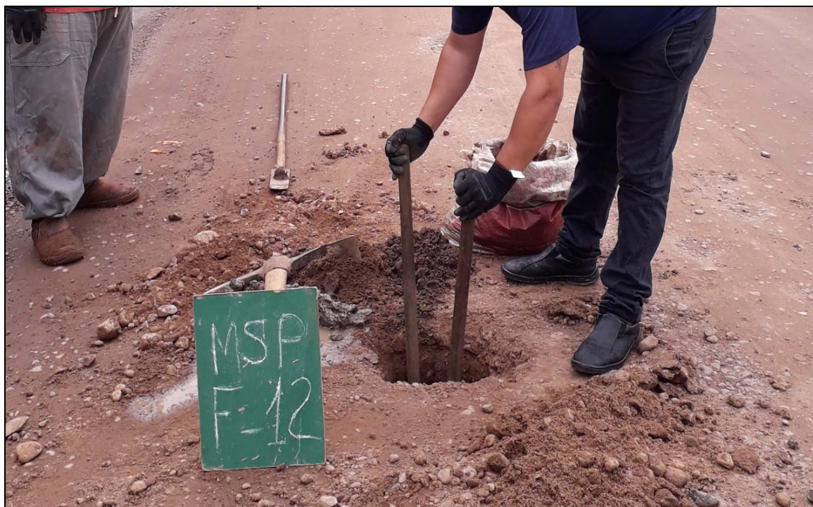
FURO DE SONDAGEM - MSP F-12
