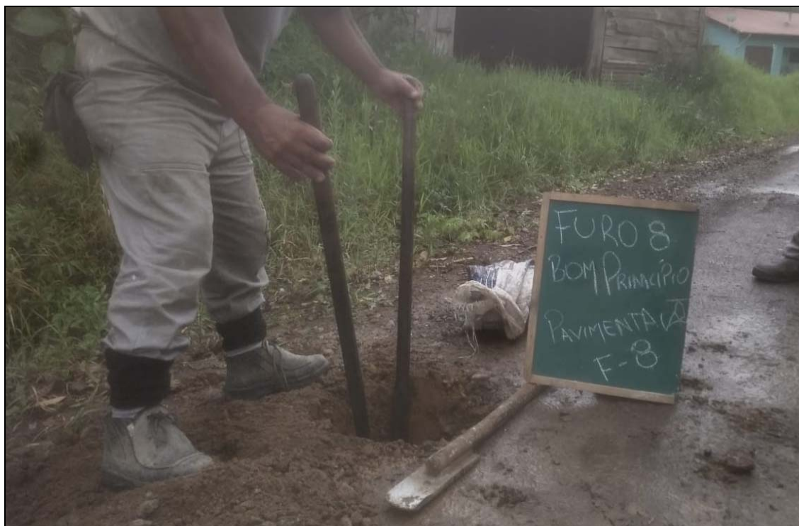
FURO DE SONDAGEM - MSP F-8
