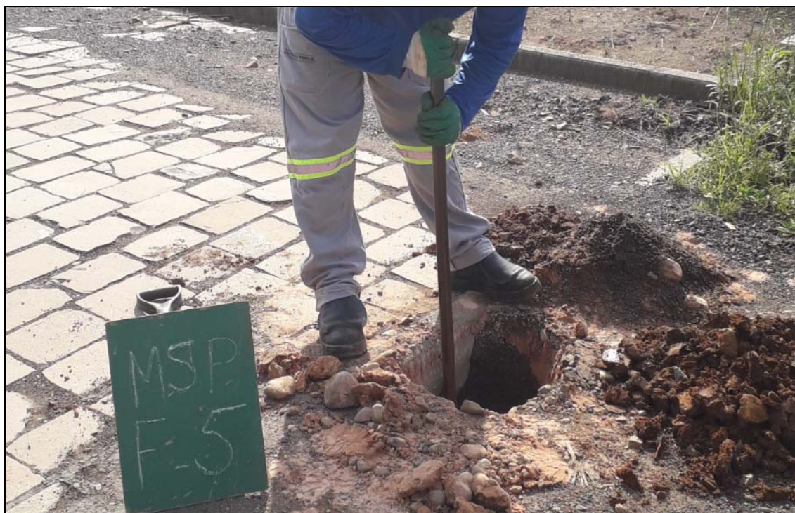
FURO DE SONDAGEM - MSP F-5
