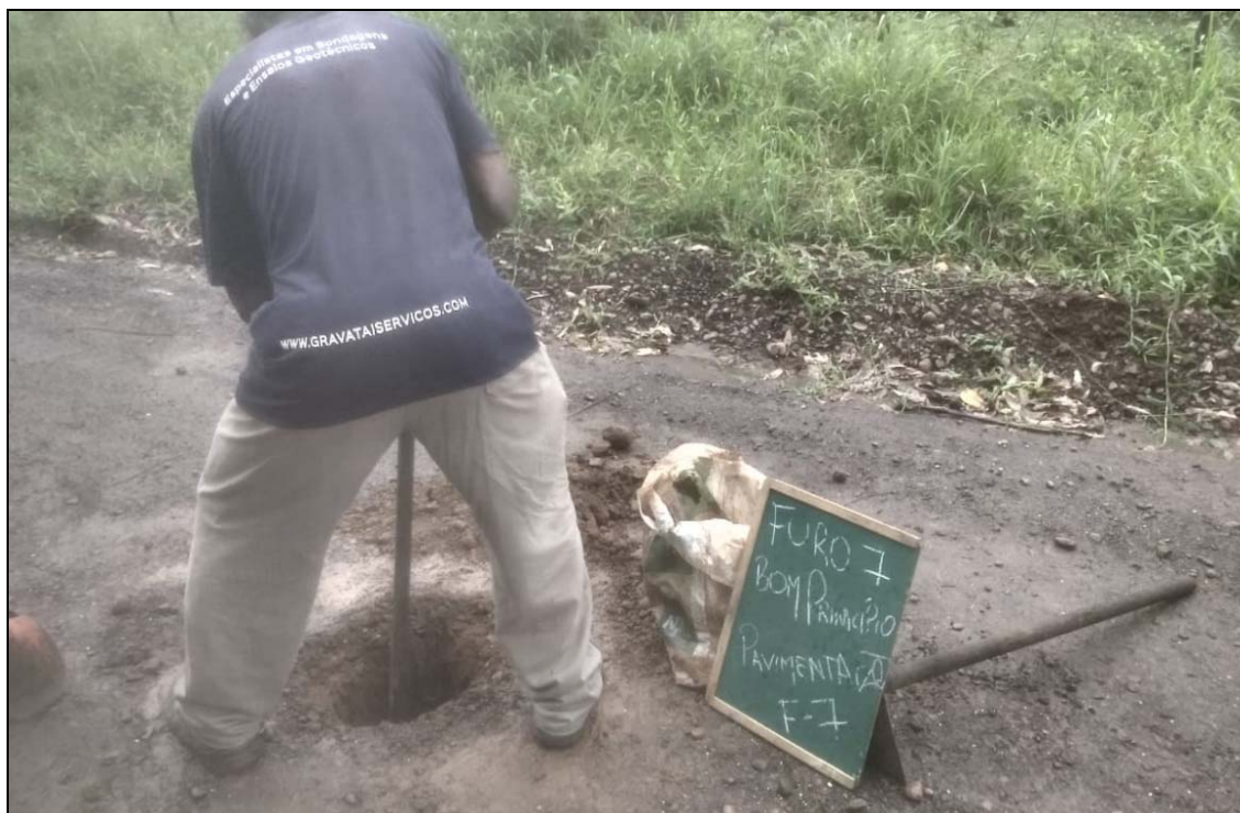
FURO DE SONDAGEM - MSP F-7
