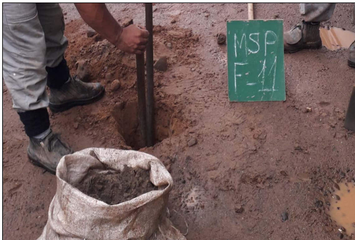
FURO DE SONDAGEM - MSP F-11
