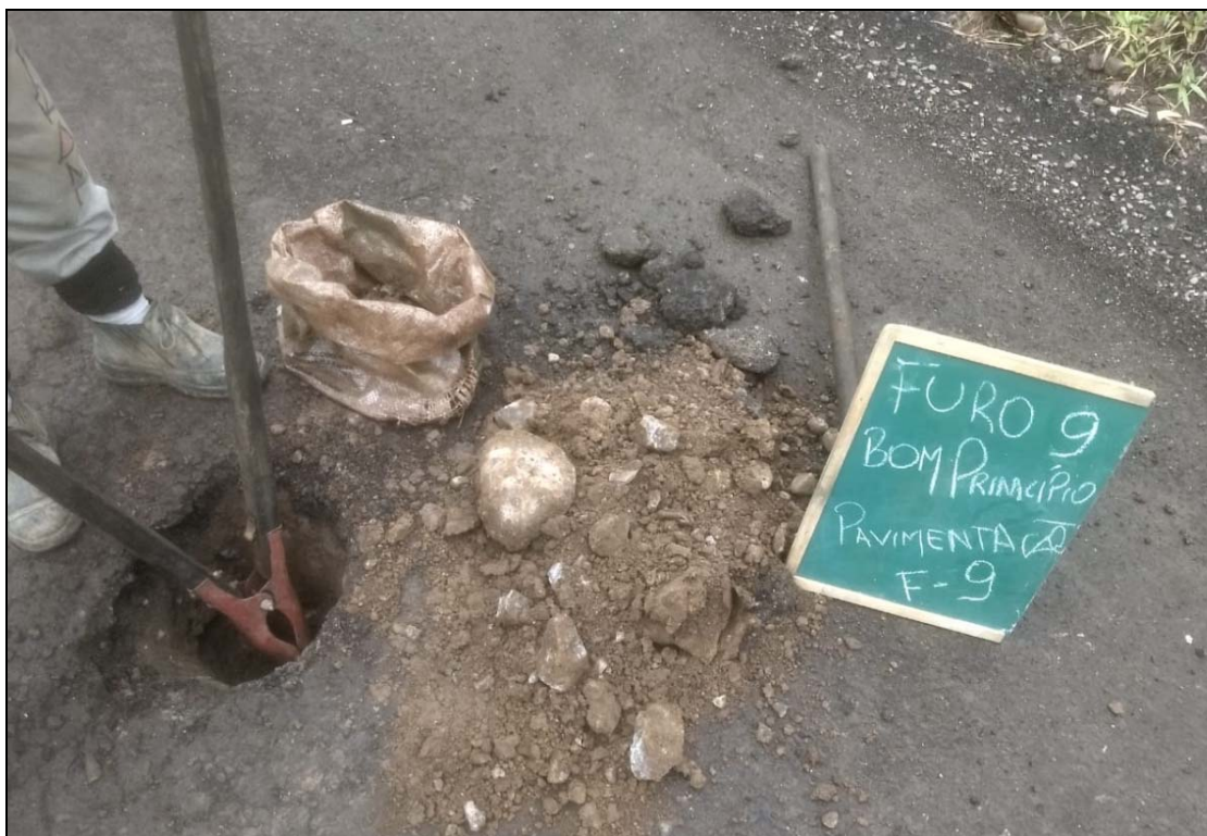
FURO DE SONDAGEM - MSP F-9
