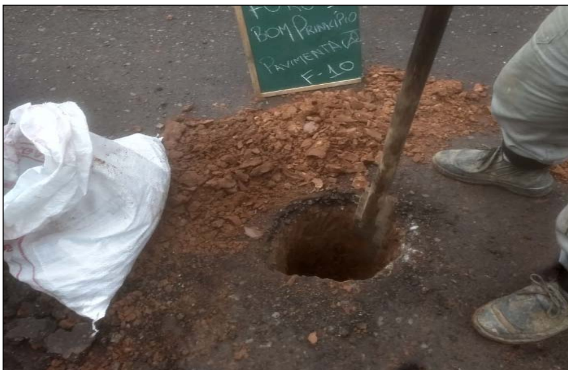
FURO DE SONDAGEM - MSP F-10
