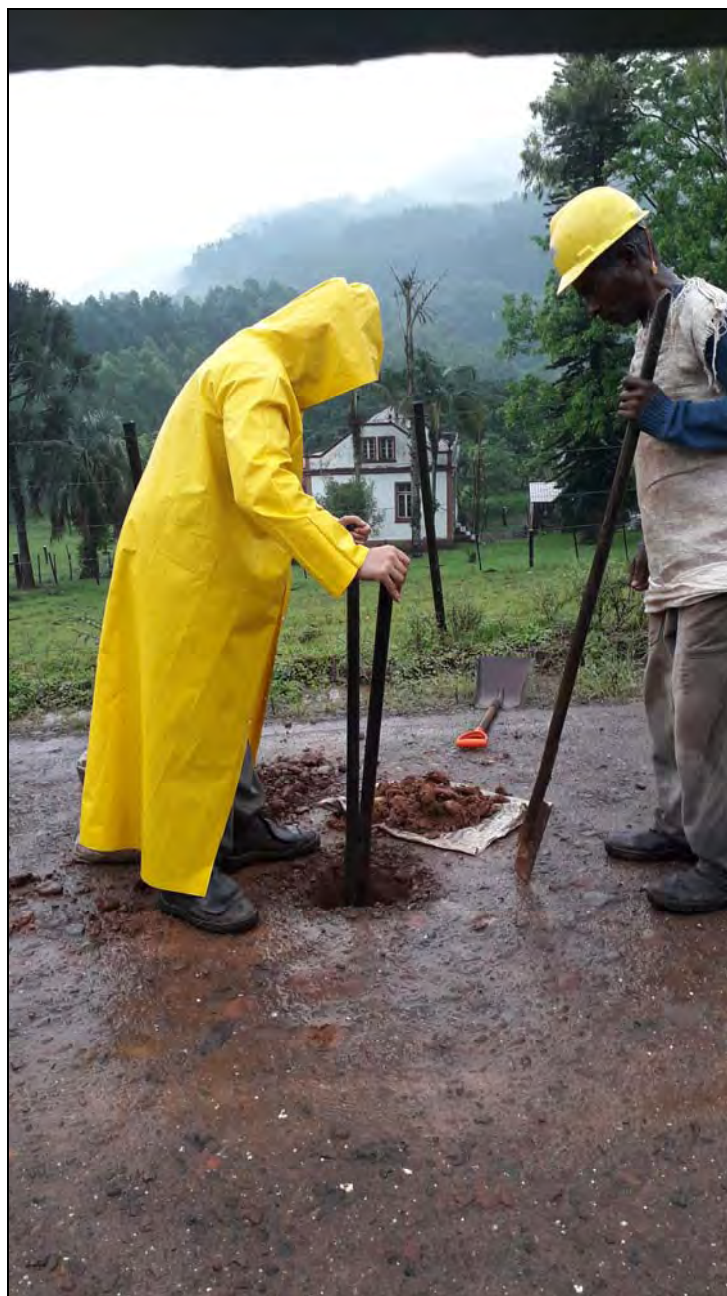
FURO DE SONDAGEM - BFA2 - F4
