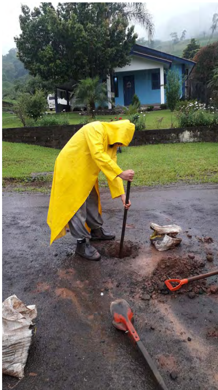
FURO DE SONDAGEM - BFA2 - F5
