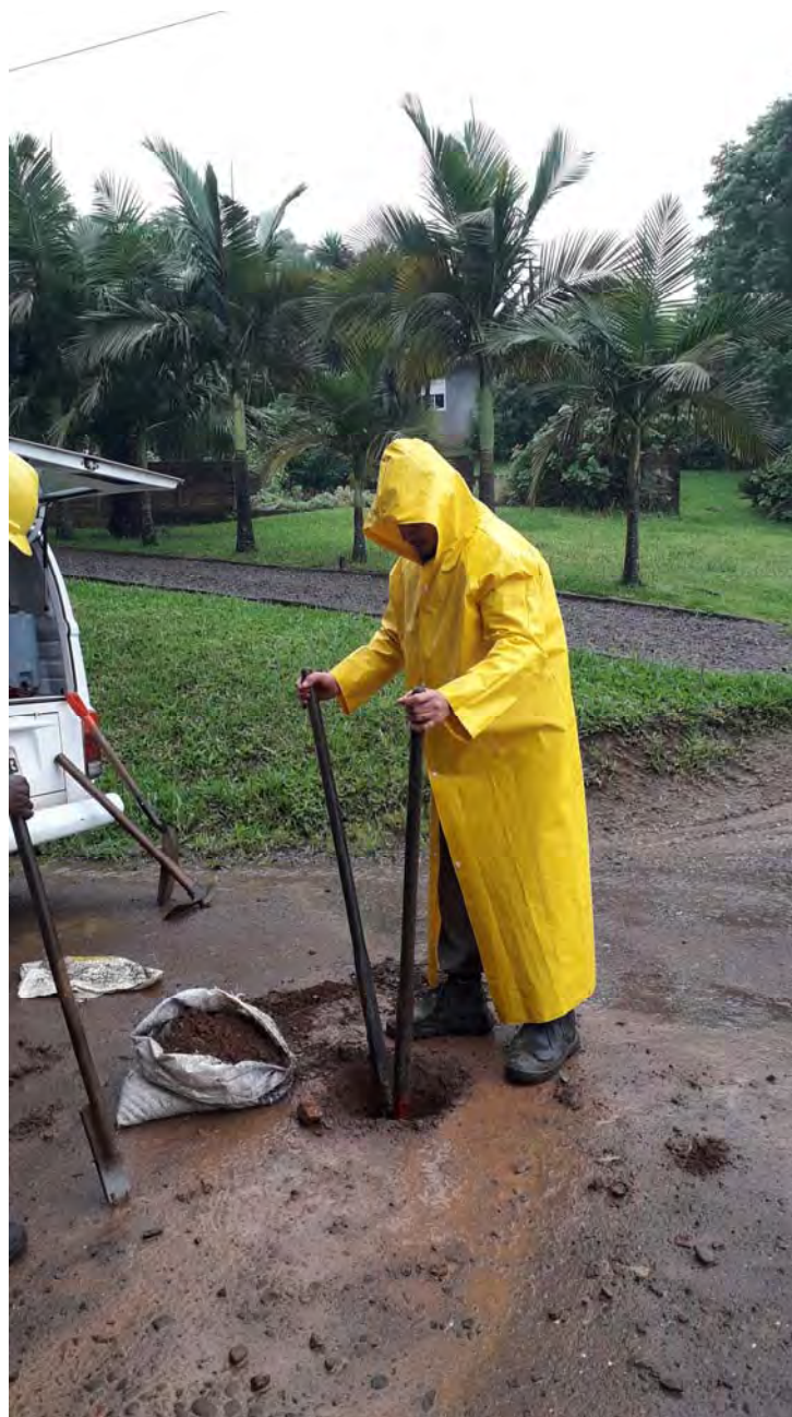
FURO DE SONDAGEM - BFA2 - F6
