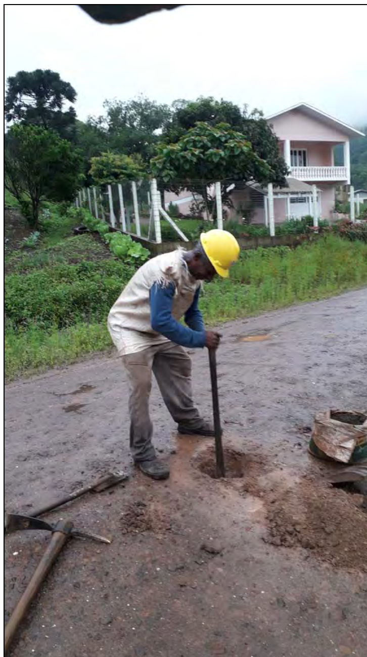
FURO DE SONDAGEM - BFA2 - F3
